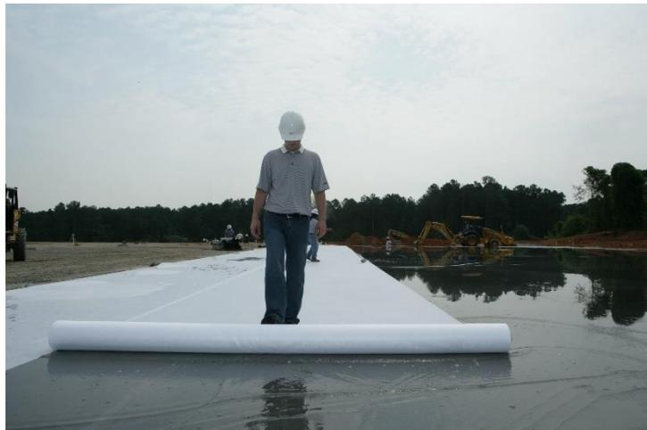
**Figura 3-19: Curado con papel impermeable**
