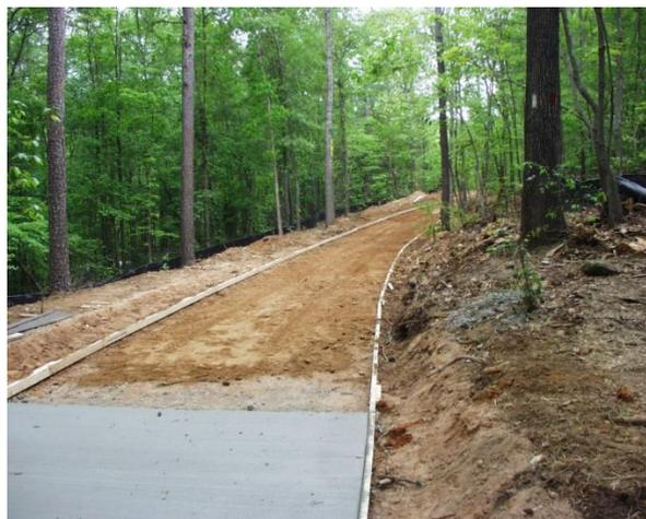
**Figura 3-17: Curado con aserrín**
