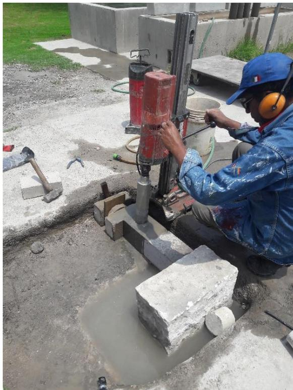
**Figura 4-18: Extracción de testigos diamantinos**
