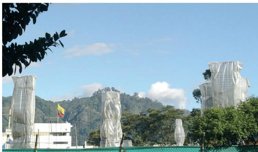
**Figura 3-18: Curado con láminas de polietileno**
