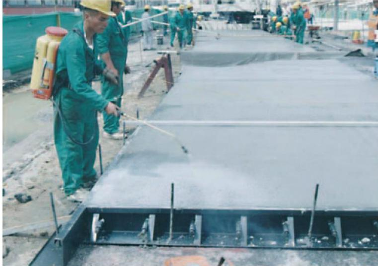
**Figura 3-20: Curado con compuestos líquidos**
