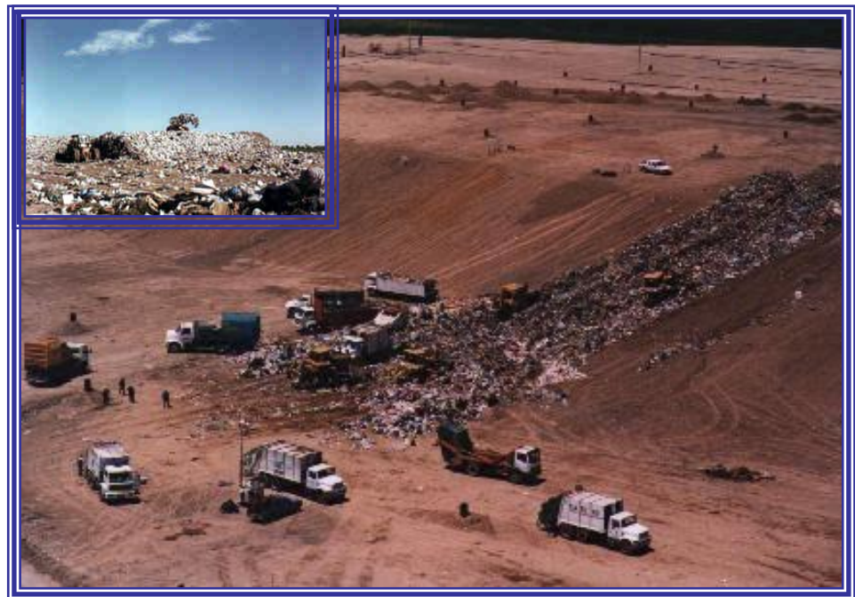
Figura No. 2 Vista de un Relleno en Funcionamiento
