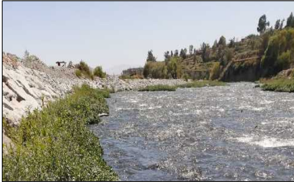
Figura No. 3.10. Vista de la Zona 05, correspondiente al Puente Tiabaya
