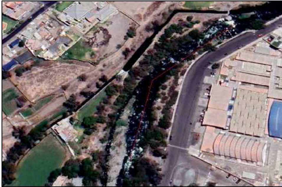
Figura No. 3.5. Zona 03, correspondiente al Puente San Martín
