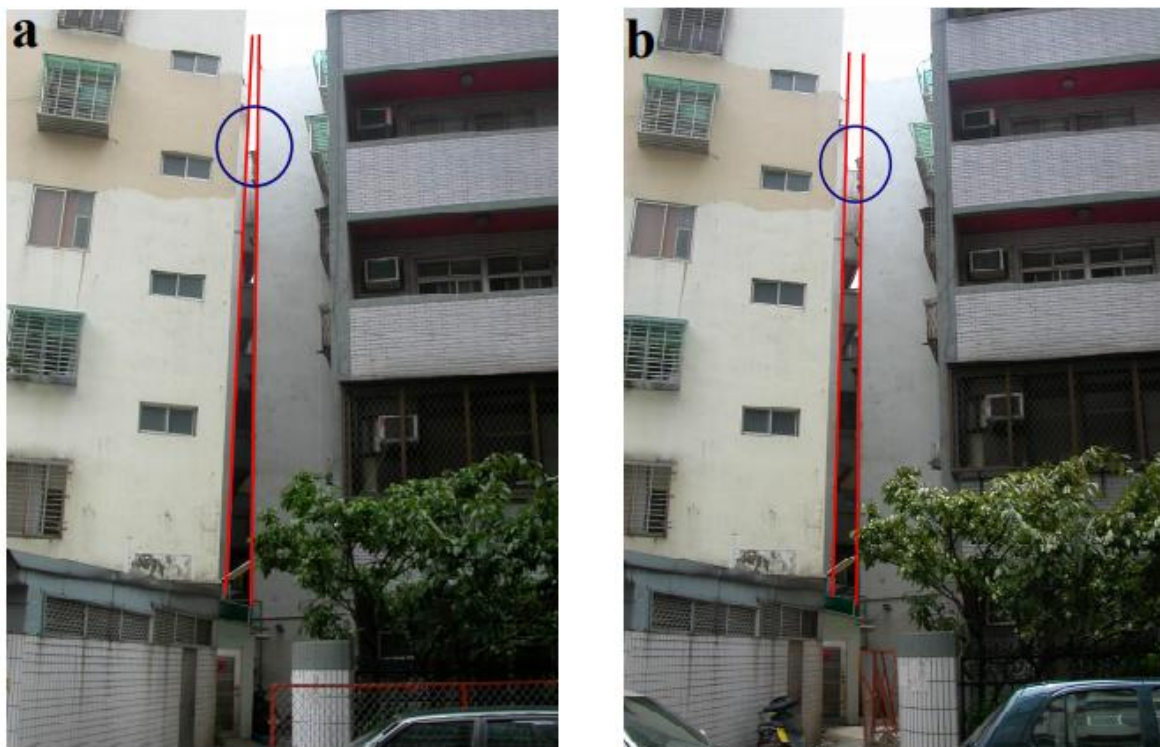
Figura 2.23. Rendimiento de la lechada a) Antes del tratamiento b) Después del tratamiento
