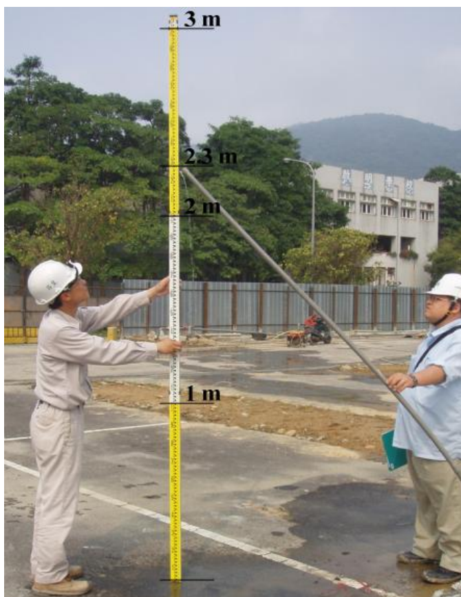
Figura 2.16. El nivel de agua subterránea a 2.3m antes de la excavación en el sitio B
