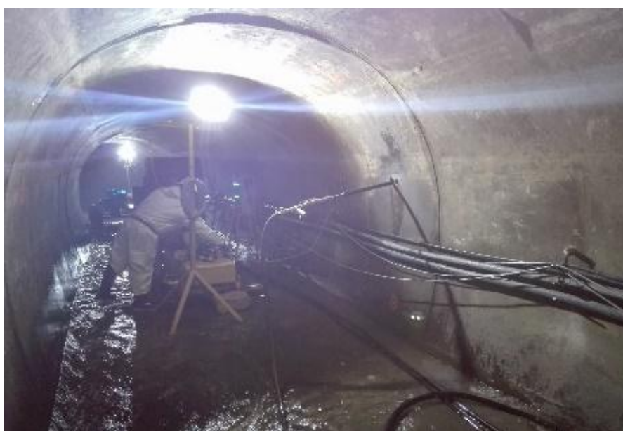
Figura 5.19. Instalación del equipo de inyección para las inyecciones de cuarta etapa.
