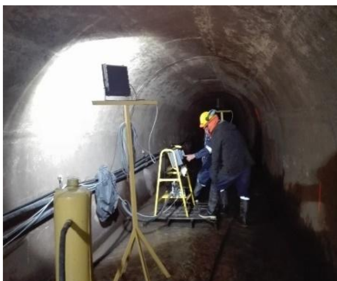
Figura 5.7. Instalación del equipo de inyección.
