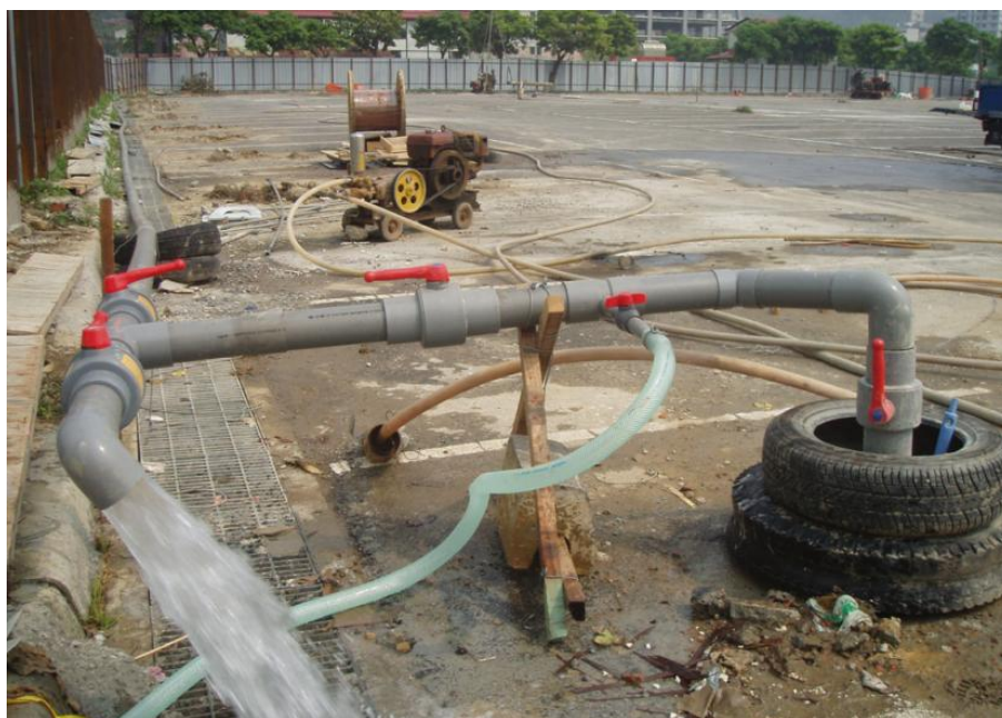
Figura 2.17. Flujo sin bombeo de la capa de arena y grava en la zona B
