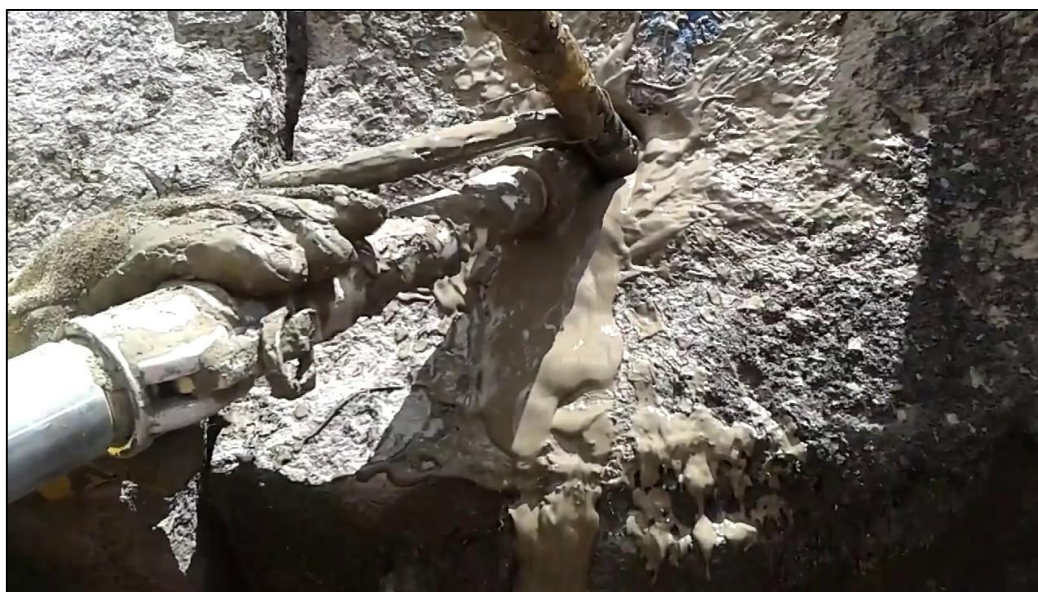
Figura 2.2. Inyección de lechada.
